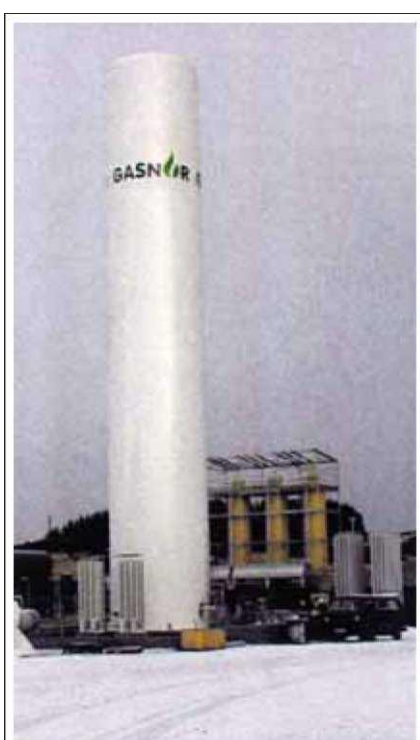
Емкость для хранения на 257 000 литров СПГ с насосом для заправки автотрейлеров, расположенная на заводе Gasnor в Snurrevarden в Норвегии
