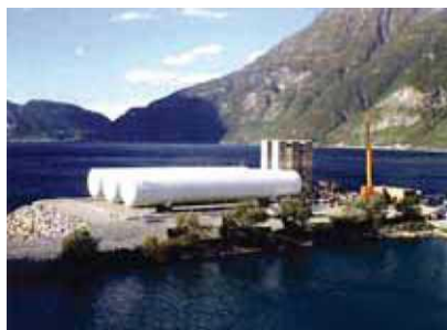
Станция-приемник для СПГ, поставленная под ключ для ИаЮгдазз УезГ Норвегии, с объемом хранения 1 500 000 литров и производительностью 3000 Нм 3 /час обеспечивает газом алюминиевый литейный завод
